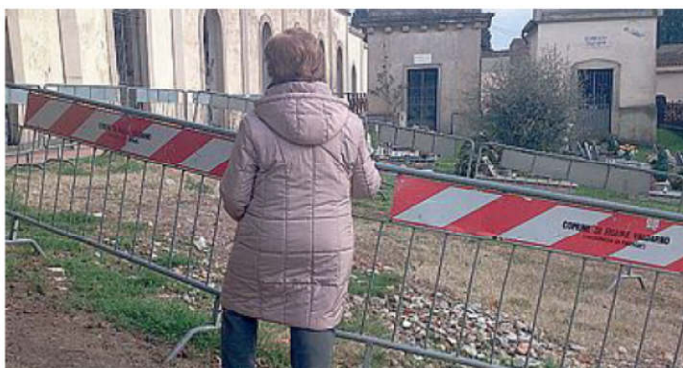
Il cimitero dei Ciliegi dopo un anno è sempre un cantiere «chiuso»
